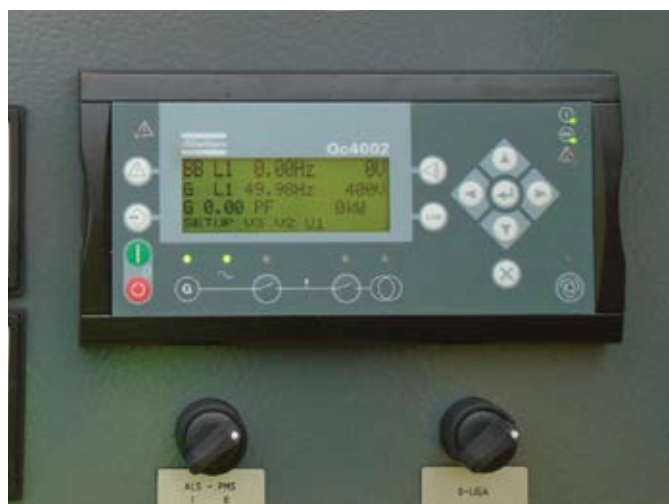
Панель управления с возможностью синхронизации работы (опционально)
